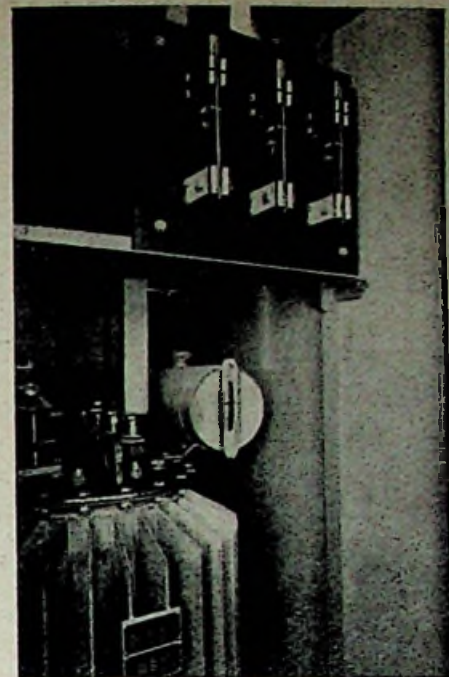
Scheidingswand van Pierrite CO voor hoogspanningsruimten
